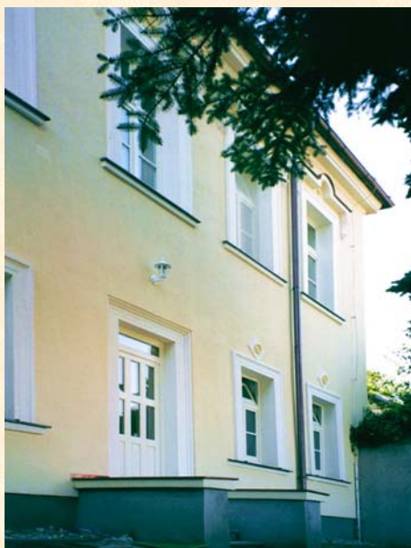
Výhody zateplovacieho systému STYREXON® sa plne využili pri rekonštrukcii barokového domu na Nitrianskom hrade.
