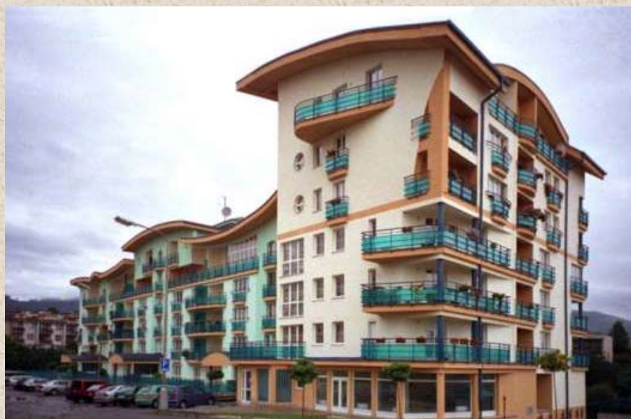
Polyfunkčný dom v Banskej Bystrici vďaka nehorľavosti STYRCONu prežil požiar v r 1999, necelé dva týždne pred kolaudáciou.
